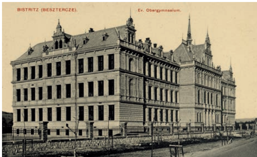
Das neue Gymnasialgebäude um 1910 Foto: Sammlung Günter Klein
